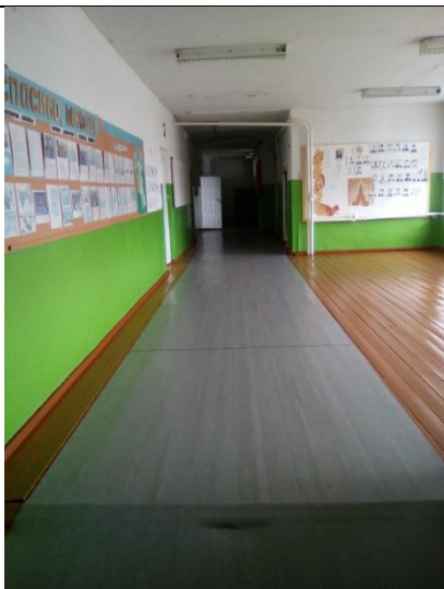
№ 27 эвакуационный путь, 2 этаж
