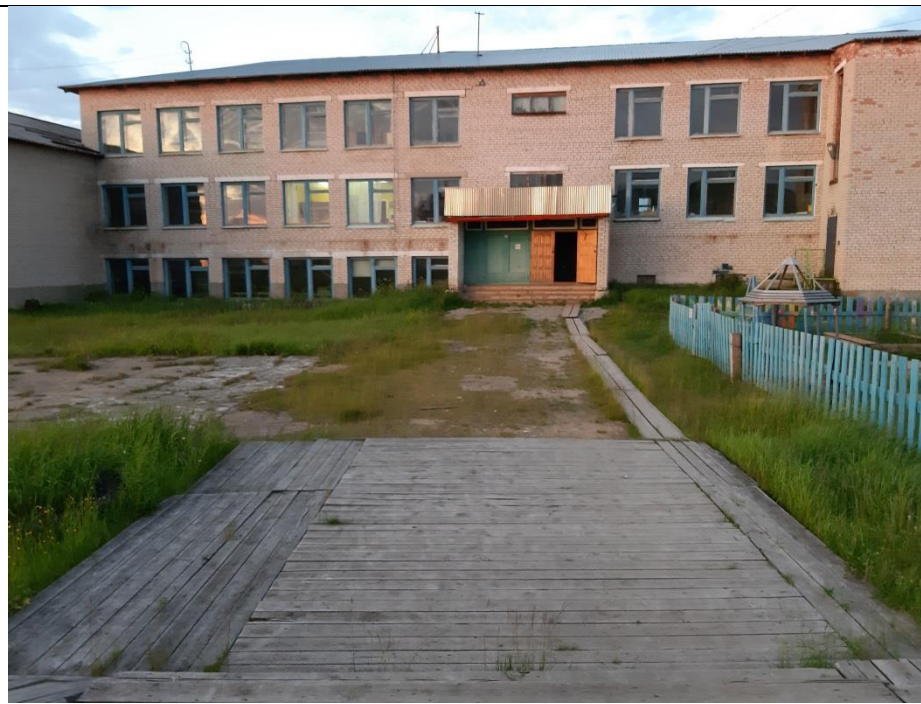
Фото №2, основной вход
