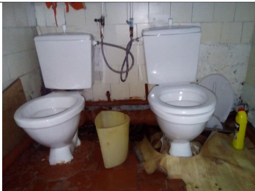
№30, санузел для обучающихся(дев), цокольный этаж, школа
